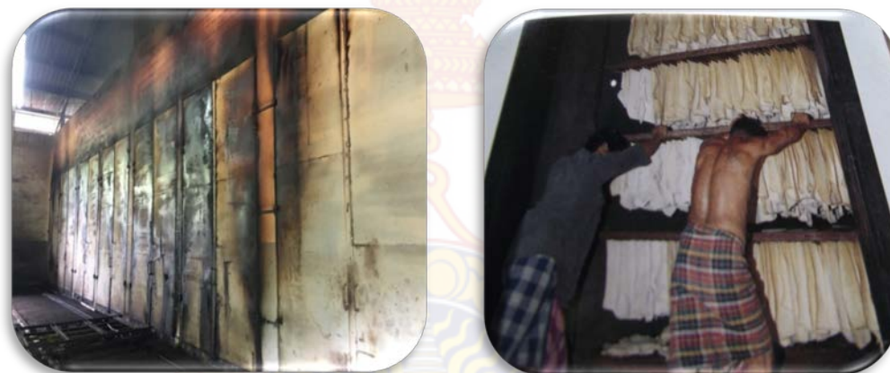
ภาพที่ 1.1 สภาพบริเวณพื้นที่ห้องอบรมควันยางแผ่นพารา
