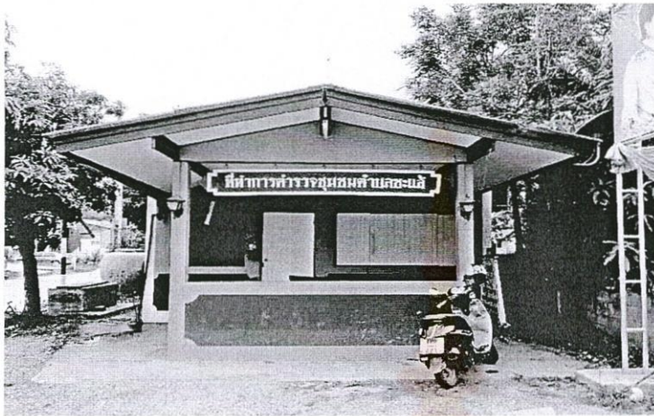
ภาพที่ 2.11 ที่ทำการตำรวจชุมชนตำบลชะแล้
