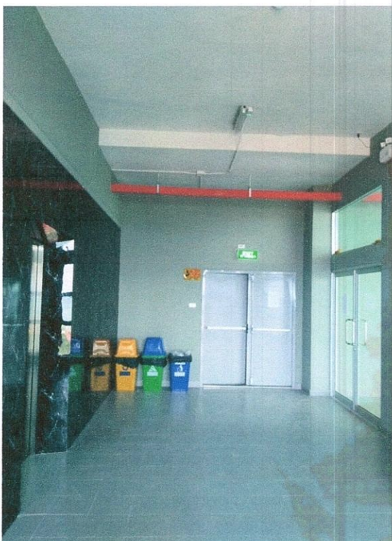
รูป 3.15 ทางออกฉุกเฉินส่วนหน้าอาคาร
