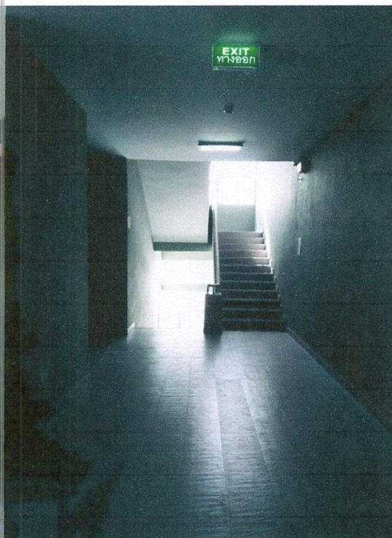
รูป 3.16 ทางออกฉุกเฉินบริเวณส่วนท้ายอาคาร
