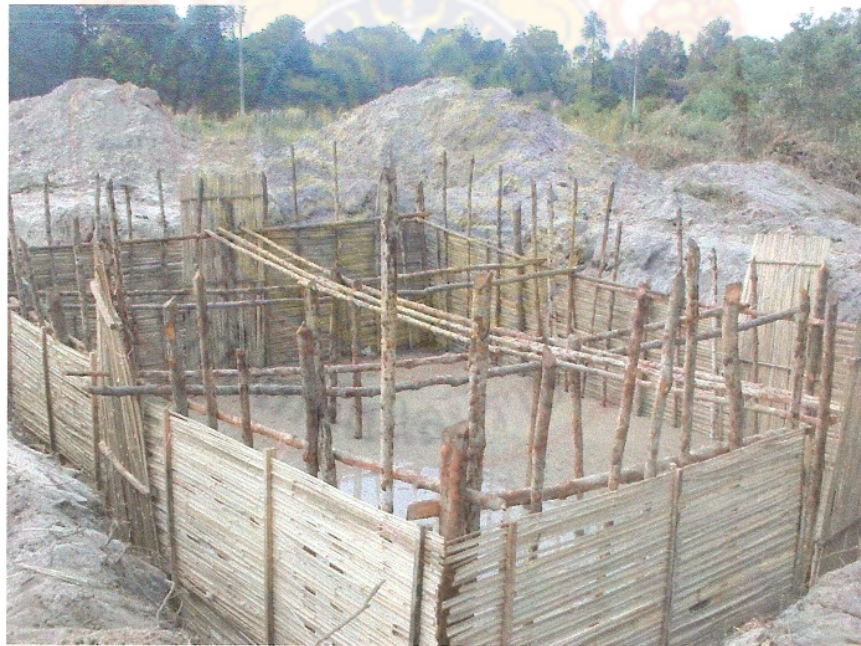
รูปผนวกที่ 6 บ่อบำบัดที่กั้นไม้ไผ่สานเสร็จแล้ว แต่ยังไม่ได้ถมดินค้นบ่อ
