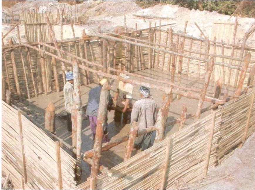
รูปผนวกที่ 5 การทำราวสะพานสำหรับผูกกระชัง และเดินภายในบ่อ
