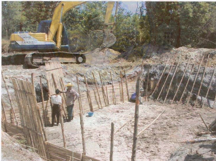
รูปผนวกที่ 4 ทำการปักหลักเสาเข็ม กั้นดินพังทะลายด้วยไม้ไผ่สานในบ่อบำบัดน้ำทิ้ง
