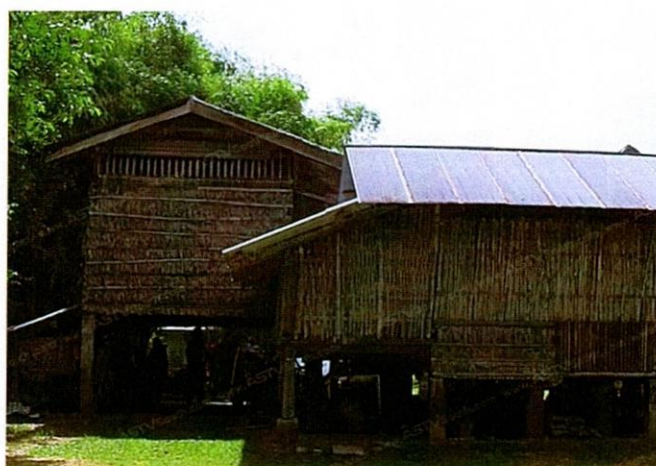
ภาพที่ 3.2 ด้านหลังของเรือนพักอาศัยพื้นถิ่น ตำบลรำแดง อำเภอสิงหนคร จังหวัดสงขลา แหล่งที่มา ภาพในพื้นที่จริง (สาทิณี, 2559)
