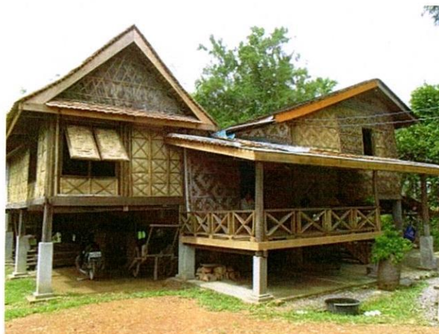
ภาพที่ 3.1 เรือนพักอาศัยพื้นถิ่น ตำบลรำแดง อำเภอสิงหนคร จังหวัดสงขลา แหล่งที่มา ภาพพื้นที่จริง (สาทิณี, 2559)
