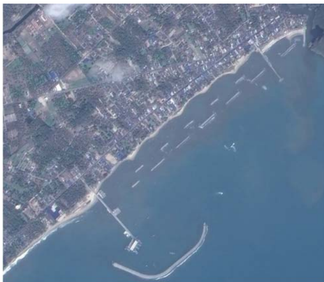
ภาพที่ 2 บริเวณที่มีสิ่งก่อสร้างประกอบด้วยสะพานท่าเทียบเรือเชื่อมฝั่งขนาด กว้าง×ยาว 10×420 เมตร เชื่อมกันคลื่นโค้งความยาว 700 เมตร จำนวน 1 ตัว และมีเขื่อนกันคลื่นขนาดเล็ก (Detached Breakwaters) จำนวน 12 ตัว
