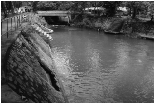
ตำแหน่งที่ 13 บริเวณทำนบน้ำบริเวณหัวสะพานท่าแพใต้
