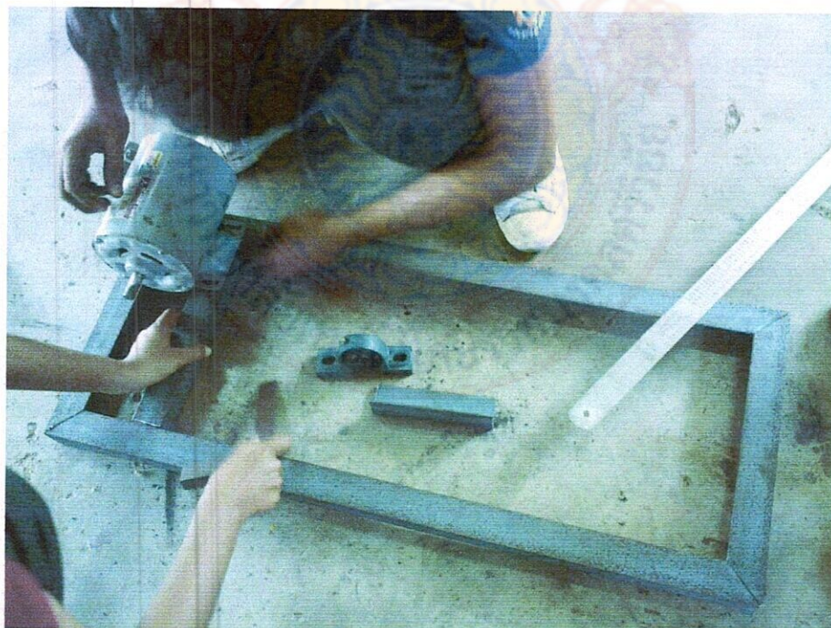
รูปที่ 3.10 แสดงการประกอบมอเตอร์เข้ากับฐานวางชุดส่งกำลัง
