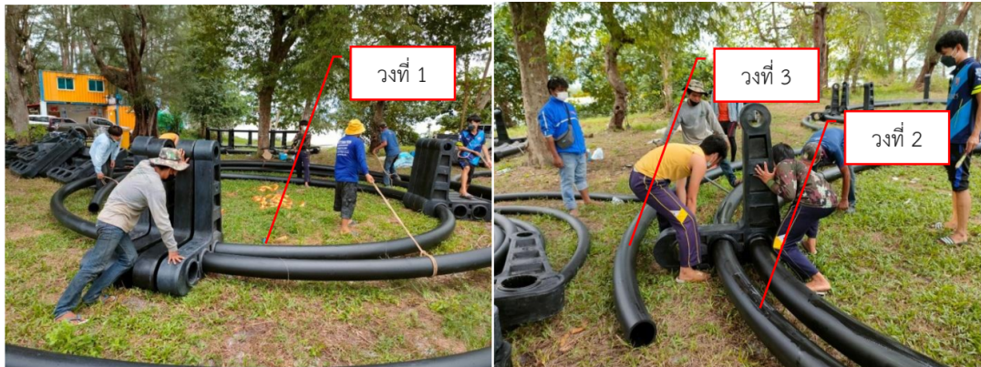
ภาพที่ 18 การติดตั้งชิ้นส่วนเชื่อมต่อเข้ากับท่อขดกลมวงที่ 1 - 3
