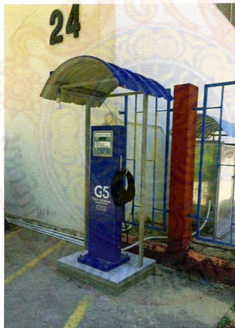
ออกแบบและสร้างหลังคาถ้ำกันฝนของเครื่องเติมลมยางอัตโนมัติ
