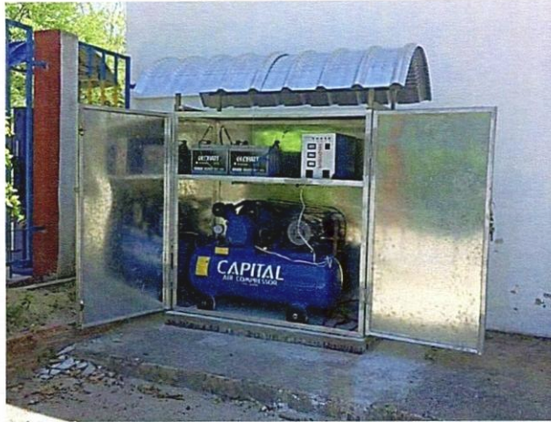
รูปที่ 3.13 การติดตั้งตู้เก็บอุปกรณ์เครื่องเติมลมพลังงานแสงอาทิตย์สถานทำงานจริง
