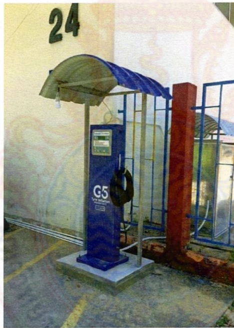
รูปที่ 3.14 การติดตั้งเครื่องเติมลมยางอัตโนมัติสถานทำงานจริง
