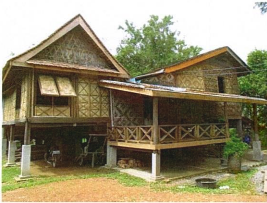
ภาพด้านหน้าเรือนพักอาศัย
