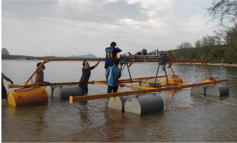
ภาพที่ 3-8 ติดตั้งฐานรับน้ำหนักหลัก
