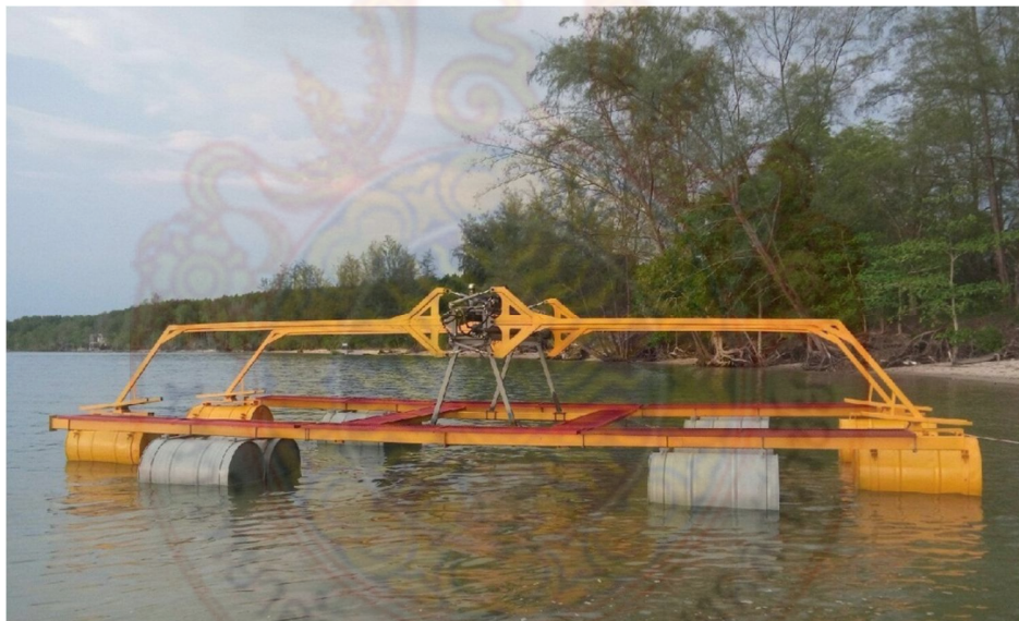
ภาพที่ 3-11 ติดตั้งระบบผลิตพลังงานไฟฟ้าด้วยคลื่นในทะเลเสร็จสมบูรณ์
