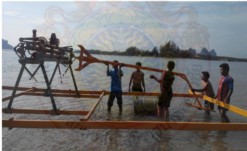
ภาพที่ 3-9 ติดตั้งแกนไฮดรอลิก
