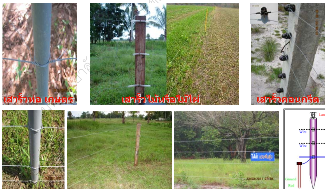
ภาพที่ 31 การติดตั้งลวดและฉนวนสำหรับยึดติดกับเสารั้วชนิดต่าง ๆ
