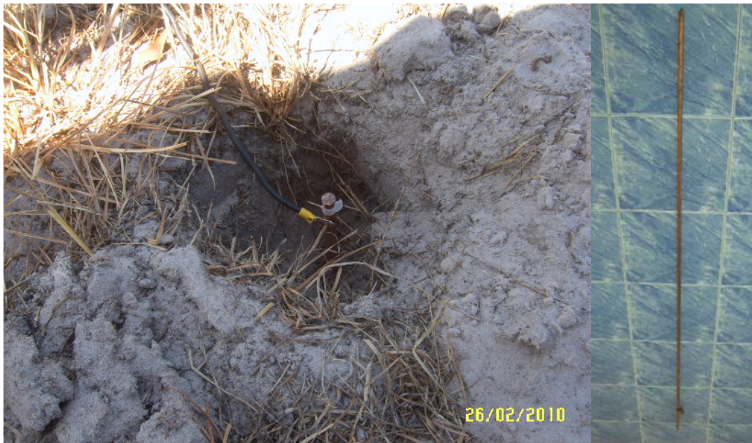
ภาพผนวกที่ ข.4 การติดตั้งแท่งกรวดขนาด 2.4 เมตร
