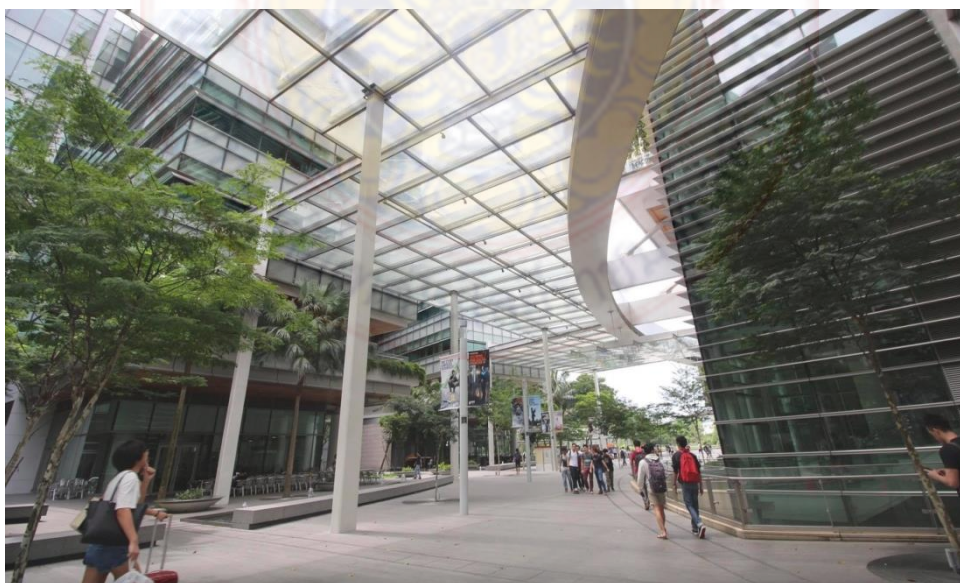
ภาพที่ 4-69 แสดงทางเข้าหลัก บริเวณอาคาร Create NUS
