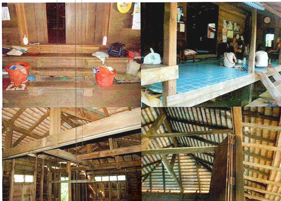
ภาพที่ 4.5 แสดงการสอดสลัก เข้าเตี้ย เจาะ บาก ส่วนต่าง ๆ ของเรือน ที่มา ภาพถ่ายจากสถานที่จริง
