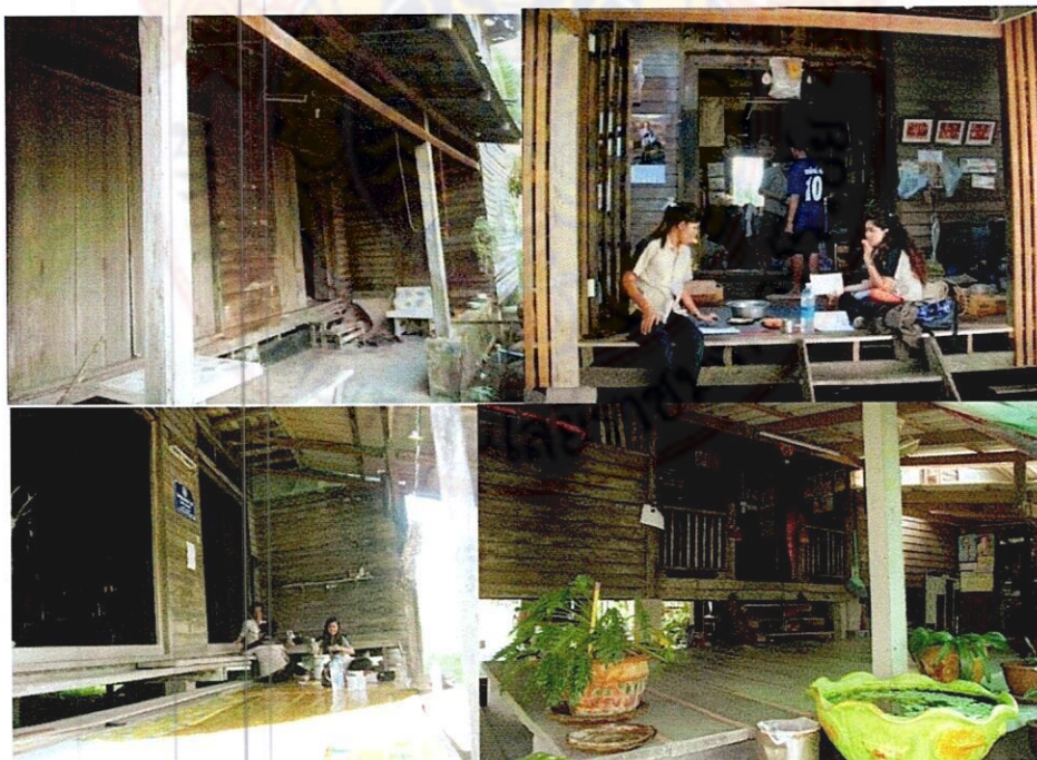
ภาพที่ 4.3 แสดงการทำระดับพื้นชานให้ต่ำกว่าพื้นเรือน ที่มา ภาพถ่ายจากสถานที่จริง
